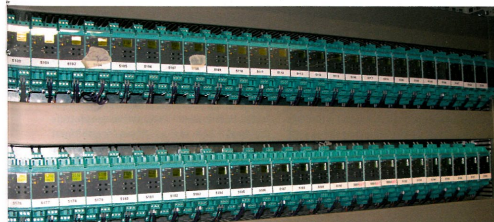
Die Signaltrenner gehören zum K-System und werden auf dem Power Rail montiert
