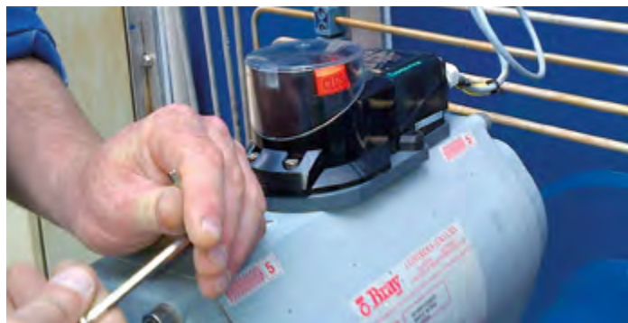
Le F31K2 se monte facilement sur l'actionneur pneumatique. Le détecteur est directement fixé au boîtier d'entraînement et la came doit être montée sur l'arbre d'entraînement, puis fixée en fonction de la position courante de la vanne.
