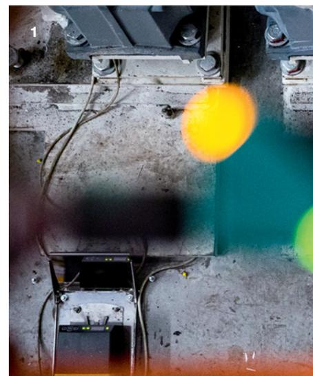
1) Le télémètre de la série VDM100 transmet des impulsions laser à un réflecteur situé sous l'ascenseur, à l'aide de la télémétrie par impulsions (PRT, Pulse Ranging Technology). En parallèle, l'émetteur du coupleur de données optiques LS680 transmet les données à l'unité de réception installée sur l'ascenseur via le protocole Fast Ethernet.
