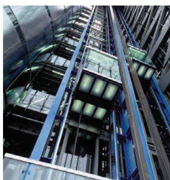
■ 电梯使用编码器确认轿箱楼层
